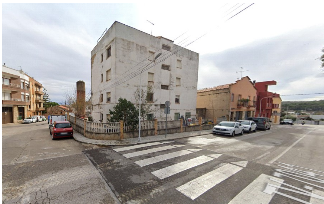
Vista carretera Mont-ral
